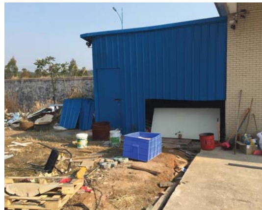
液氮储罐区现状
