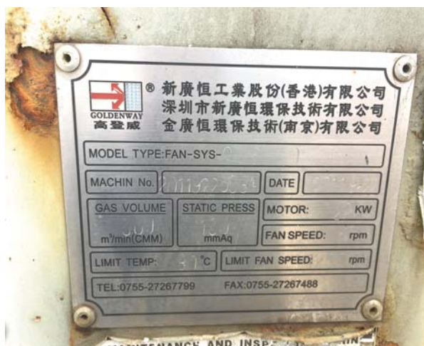
酸性废气处理风机铭牌
