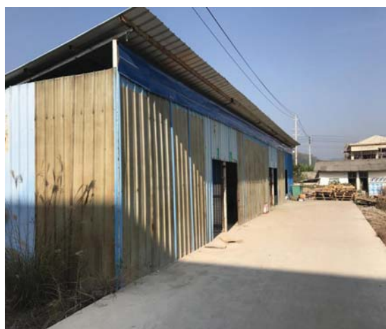
危废暂存地全貌
