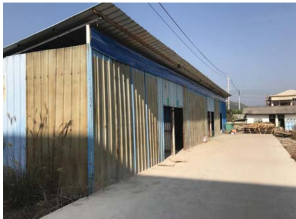
一般固废和危废暂存仓库
