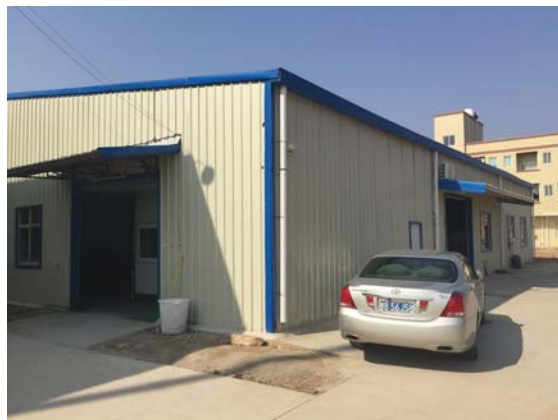
喷锡车间和原料暂存库
