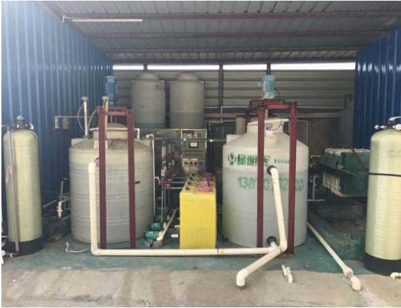
含镍废水及含氰废水处理工艺
