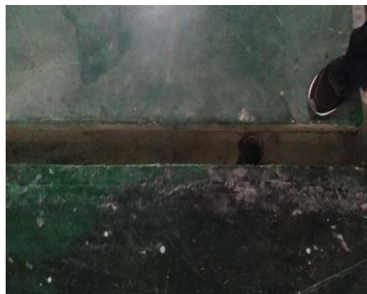
车间地面排水沟
